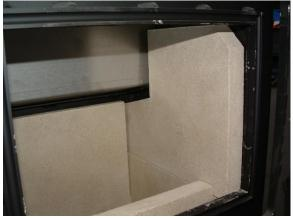
6) INSERT THE TOP RIGHT HAND BRICK (990-SF-SK-104-RH) SO THAT THE CHAMFER IS TO THE REAR AND SIDE OF THE FIRE BOX
