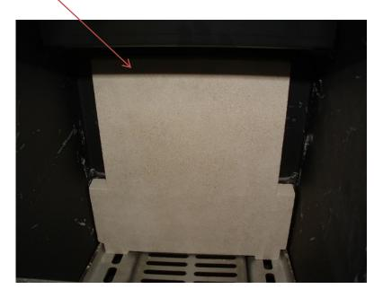
2) INSERT THE BACK BRICK (990-SF-SK-102) WITH THE CHAMFER TO THE TOP AND AGAINST THE BACK OF THE FIRE BOX
